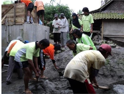
Gambar 4. Proses Pembuatan Bak Reservoir
