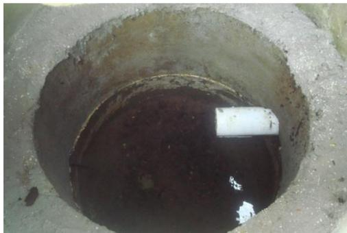
Gambar 3. Bak Penangkap Air di hulu
