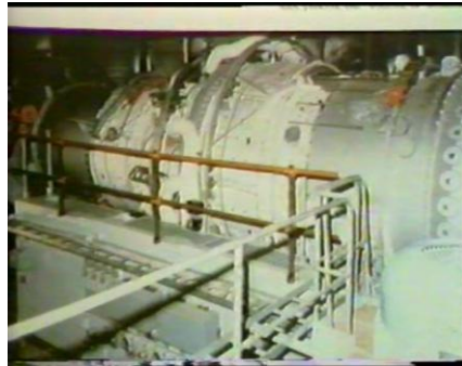
Gambar 1.2. Komponen mesin serempak, penguat, dan sistem pengatur di sebuah industri energi listrik.
