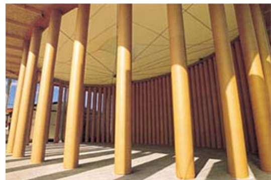
Gambar 2.2. Gereja takatori rancangan Shigeru Ban. Selesai dibangun minggu ke-5 pasca gempa, luas 10 x 15 m 2 untuk 80 tempat duduk, disusun dari 58 buah kertas silinder dengan ketebalan 15mm (panjang 5 m, diameter 330 mm).
