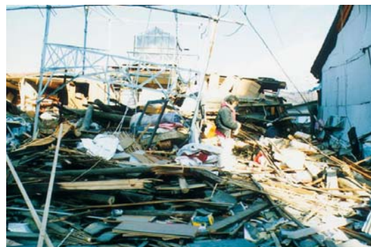
Gambar 3.3. Salah satu bangunan kayu yang runtuh secara keseluruhan
