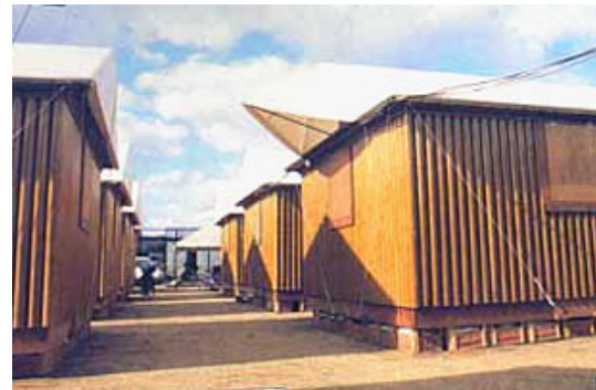
Gambar 2.1. Rumah sementara rancangan Shigeru Ban. Pondasi kotak bir berisi pasir, dinding pipa kertas, atap dan plafon tenda vinil yang dipasang terpisah
